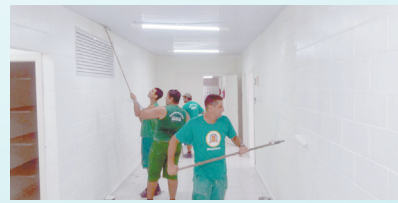
Pintura do Serfis - corredores e salão do atendimento - Bom Retiro
