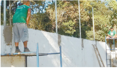
Instalação de tela e alambração no Núcleo da Escola Total - Caruara
