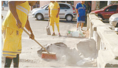
Retirada de entulho canal da Av. Campos Sales - Vila Mathias
