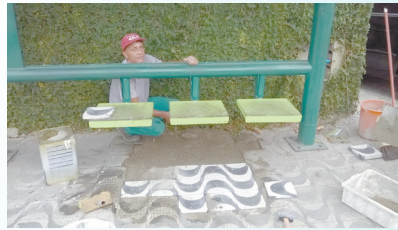
Reparo em calçada de ponto de ônibus na Praça Rebouças - Ponta da Praia
