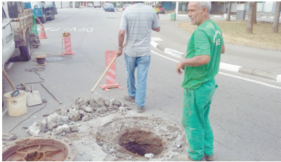
Troca de tampa de poço de visita na Praça Rebouças x Rua Jurubatuba - Ponta da Praia
