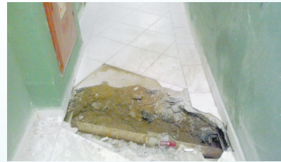
Substituição de rede hidráulica de incêndio do Arena Santos - Vila Nova
