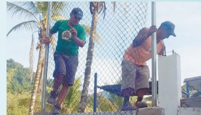
Pintura de canos e instalação de alambrado - Caruara
