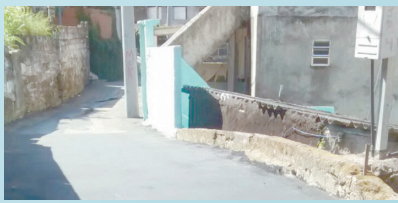
Pavimentação da Rua F - Morro José Menino
