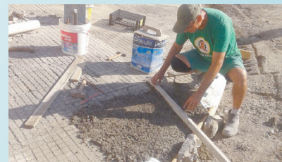
Reparos em calçadas do entorno do Mercado Municipal - Vila Nova
