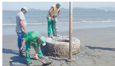
Troca da tampa do poço de visita de captação de água salgada do Aquário - Ponta da Praia
