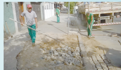
Reparo de calçada danificada na Rua Cunha Moreira - Encruzilhada
