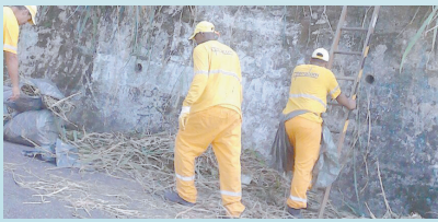
Limpeza de encosta na Rua 1 - Morro Santa Maria
