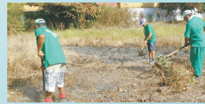
Limpeza do terreno do DER no Jardim Piratininga
