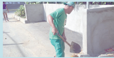
Asfalto na baía finalizado na Rua 1 - Morro Santa Maria
