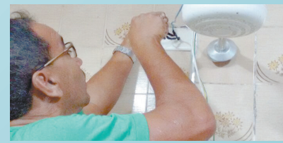
Manutenção de chuveiros na Escola Rubens Lara - Nova Cintra
