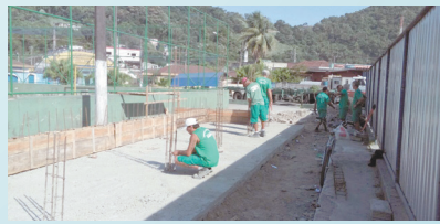
Madeiramento para concretagem da arquibancada na Praça Guilherme Délius - Alemoa
