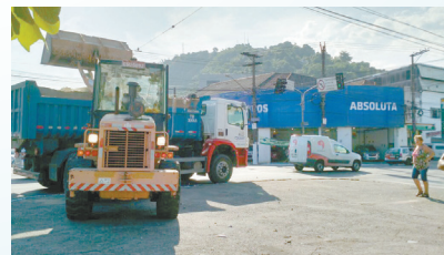
Retirada de entulho do canal da Campos Salles - Vila Mathias
