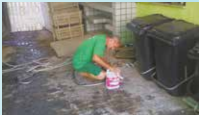
Limpeza e desobstrução da caixa de gordura na Rua 7 de Setembro - Vila Nova
