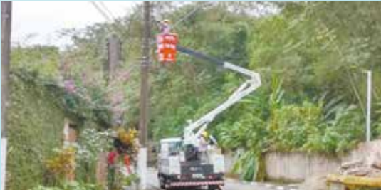
Manutenção na Rua Adilson Bulo - Nova Cintra
