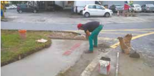
Manutenção da Praça Gomide Ribeiro - Embaré
