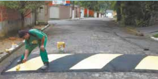
Pintura de lombadas na Rua Adilson Bulo - Nova Cintra
