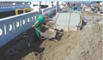
Reparo em abatimento no calçadão da praia ao lado do Canal 2 - Pompeia
