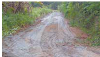
Nivelamento nas ruas Principal e Pedrosa - Iriri
