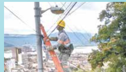
Reparo nas luminárias - Monte Serrat
