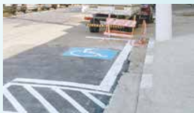
Pintura de solo em frente à UBS Vila Nova - Vila Nova
