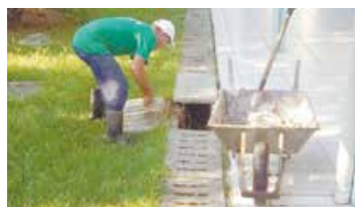
Limpeza nas canaletas de água pluvial na UME Judoca Ricardo Sampaio - Caruara
