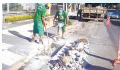
Renivelamento de sarjeta na Rua Alfaia Rodrigues - Aparecida
