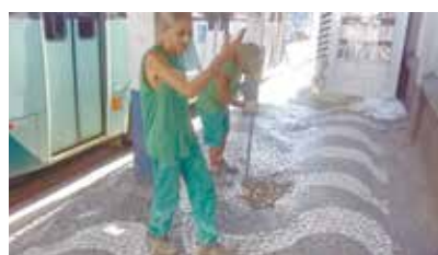
Reparo de calçada de ponto de ônibus na Av. Rei Alberto I - Ponta da Praia
