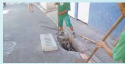
Troca de grelhas na Rua Brigadeiro Newton Braga - Saboó
