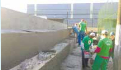
Execução de reboco na arquibancada na Praça Guilherme Délius - Vila Haddad
