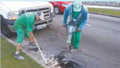
Reparo em abatimento e troca de grelha de boca de lobo na Av. Presidente Wilson - José Menino
