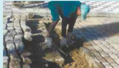
Renivelamento de paralelos na via e sarjeta da Rua Anhanguera - Vila Mathias
