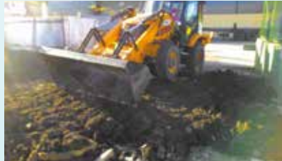
Nivelamento de piso na Praça Guilherme Delius - Vila Haddad
