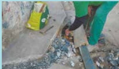
Recuperação de calçada na Travessa da Rua F - José Menino
