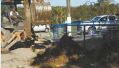
Quebra de calçada para melhoria de acessibilidade em praça - Monte Cabrão
