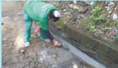
Execução de mureta para contenção de água - José Menino
