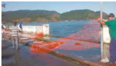
Manutenção de isolamento na Ponta da Praia
