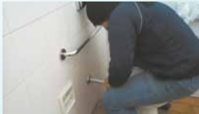
Manutenção em vasos sanitários UME Avelino da Paz Vieira - Vila Nova
