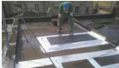
Impermeabilização da laje da Secretaria de Educação - Centro
