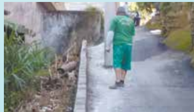
Execução de mureta do segundo trecho da Rua F - José Menino
