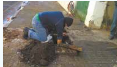
Limpeza da caixa de passagem da calha do Quêro - Vila Nova
