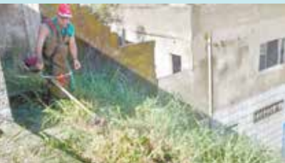
Poda na UME Regina Altman - Vila Progresso
