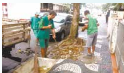
Reparo em calçada danificada por raízes de árvores na Rua Sampaio Moreira - Aparecida
