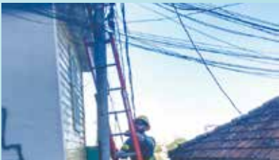
Reparo nas luminárias - Jabaquara
