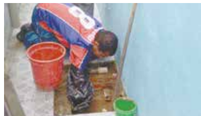
Limpeza e desentupimento de caixa de gordura na Creche Monte Cabrão
