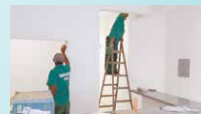
Pintura interna do SENAT - Macuco
