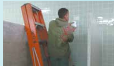
Troca de chuveiros na Arena Santos - Vila Mathias
