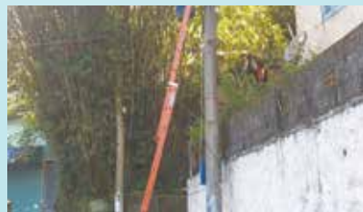
Instalação de caixa de luz na Rua Nossa Senhora de Lourdes - Morro do Fontana
