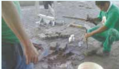
Instalação de sistema de esgoto na Arena Santos - Vila Mathias
