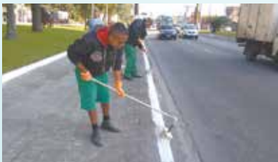
Pintura de postes e guias na Avenida Martins Fontes - Sabó
