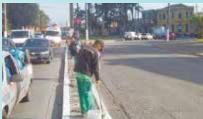
Pintura de postes e guias na Avenida Getúlio Vargas - Valongo
