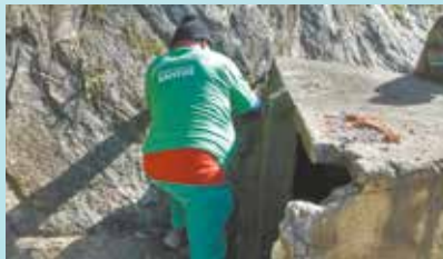
Manutenção em tampas de drenagem da Rua Santa Marta - São Bento
