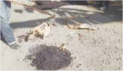
Operação tapa buraco na Rua Principal - Monte Cabrão
