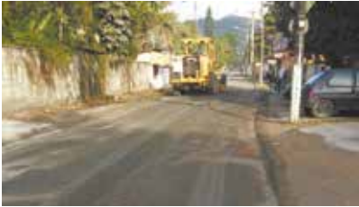
Nivelamento com bica corrida das ruas Xavantes, Caramuru e Tupy - Caruara
