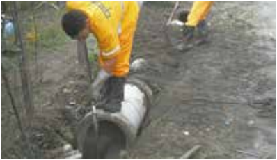
Instalação de manilhas nas ruas Galvão e Santo Antônio - Caruara
