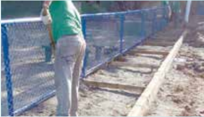
Preparação da calçada para concretagem na praça - Monte Cabrão
