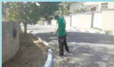
Pintura de meio fio na Rua Adilson Buló - Nova Cintra
