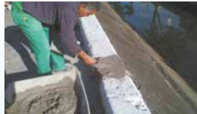
Continuação de manutenção das muretas no canal da Avenida Campos Sales - Vila Mathias
