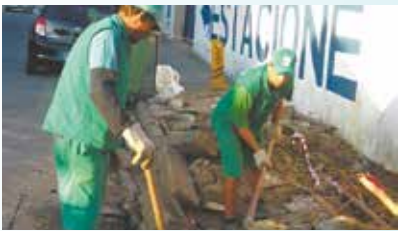
Reparo em calçada danificada por raízes de árvores
