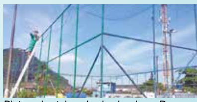
Pintura dos tubos do alambrado na Praça Guilherme Délius - Alemoa
