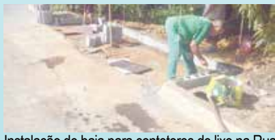
Instalação de baia para contêntores de lixo na Rua 2 - Santa Maria
