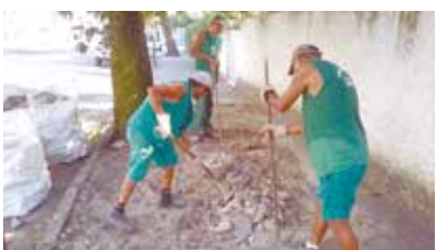
Reparo em calçada danificada por raízes de árvores na Rua Jurubatuba - Ponta da Praia
