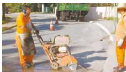
Reparo no asfalto das baias nos pontos de ônibus na Praça Encarnacion Alves Corpas - Caruara
