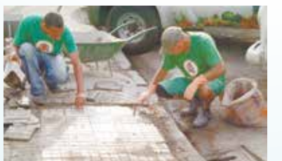
Manutenção da calçada na Praça Iguatemi Martins - Vila Nova
