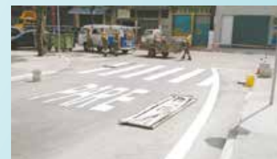
Sinalização de solo na Praça Nagasaki - Vila Nova
