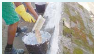
Continuação da pintura no Canal da Rua Campos Sales - Vila Mathias
