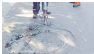
Nivelamento de tampa de poço de visita na Praça Encarnacion Alves Corpas - Caruara
