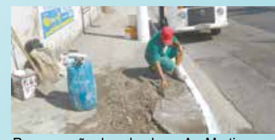
Recuperação de calçada na Av. Martins Fontes - Sabóó
