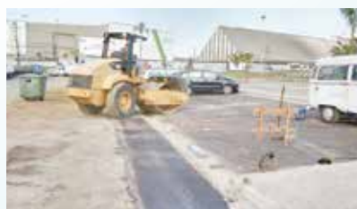
Pavimentação da Praça Nagasaki - Vila Nova
