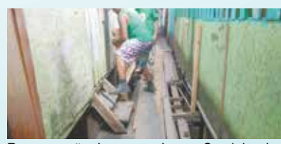
Recuperação de passarelas no Caminho da Capela, 109 - Rádio Clube
