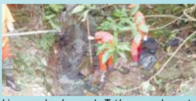
Limpeza do córrego do Tetéu em andamento - Morro do Tetéu
