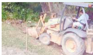
Intervenção na Marginal da Rodovia Rio-Santos para a melhoria de drenagem
