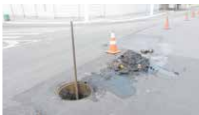
Conclusão de serviço de limpeza de galeria ao entorno da Praça Rebouças - Ponta da Praia
