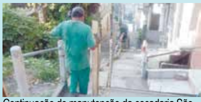
Continuação de manutenção da escadaria São Domingos - Morro São Bento
