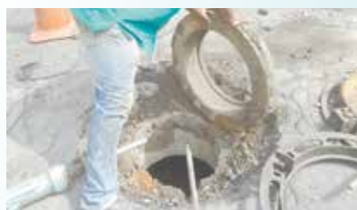
Renivelamento de poço de visita na Rua Bittencourt - Vila Nova
