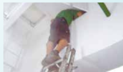
Manutenção de caixa de água na UME Avelino da Paz Vieira - Vila Nova
