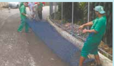
Colocação de alambreado na Rua 1 - Morro Santa Maria
