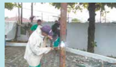
Reparo em poste de iluminação no complexo M. Nascimento - Bom Retiro
