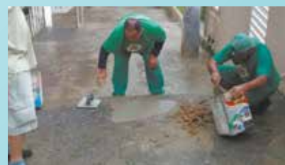
Tapa buraco nos nichos 1,2,3 e 4 - Monte Serrat
