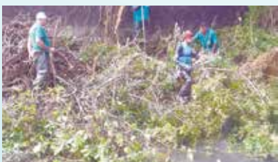
Limpeza do canal atrás da UME 28 de Fevereiro - Saboó
