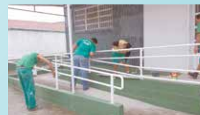
Pintura do corrimão, portões, muretas e grades do Serfis - Rádio Clube
