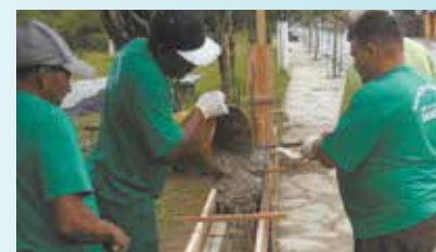
Concretagem da mureta, pintura e revestimento de cerâmica na Sociedade Esportiva de Caruara.
