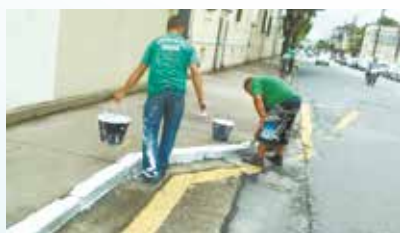
Pintura de postes e guias na Av. Rangel Pestana - Vila Mathias
