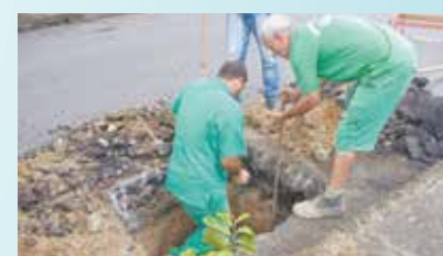
Reparo em abatimento na Av. Pedro Lessa - Aparecida
