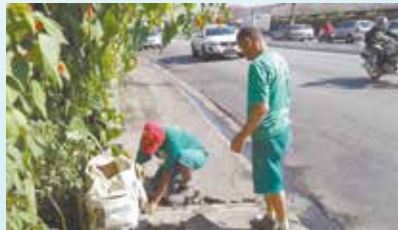
Reparo na calçada da Av. Martins Fontes - Sabão
