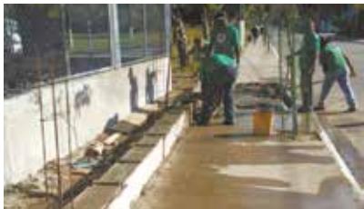
Aplicação de piso cerâmico, reparo no telhado e concretagem da viga na Soc. Esportiva Caruara
