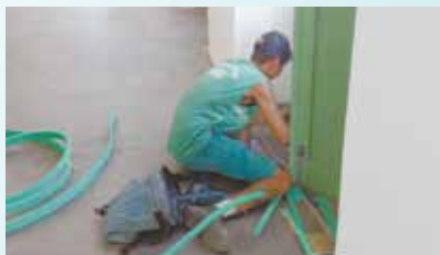
Reparo da porta no Museu Pelé - Valongo
