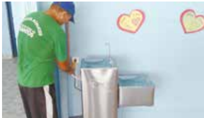
Instalação de bebedouro no pátio da UME Noel Gomes Ferreira - Caruara
