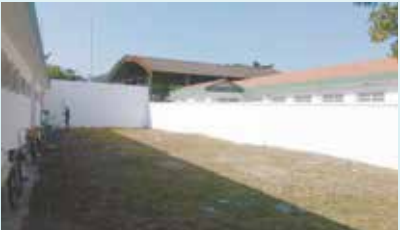
Pintura do muro do Senat concluída - Bom Retiro
