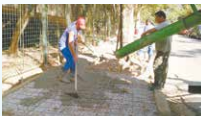
Concretagem da calçada do Teatro Municipal - Vila Mathias
