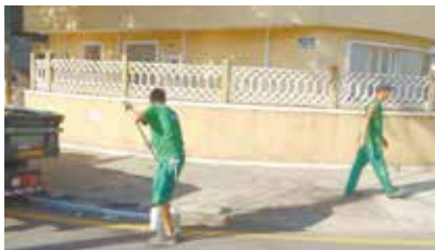
Pintura de guias na Av. Pedro Lessa - Embaré
