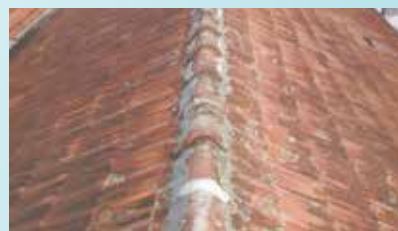
Troca de telhas da Profisc e chumbamento da cumieira - Centro
