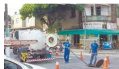
Serviço iniciado no cruzamento da Rua João Guerra com Av. Conselheiro Nébias - Macuco
