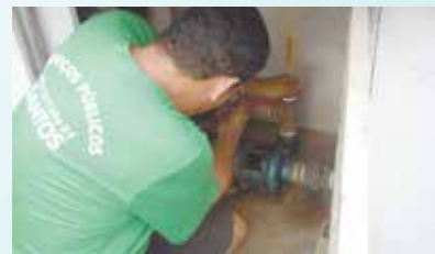
Substituição de motor na Seambesp - Vila Nova
