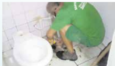
Substituição de encanamento de esgoto na Seambesp - Vila Nova
