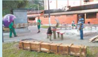
Madeiramento para construção de pilares para posterior concretagem do quiosque na Praça Otávio Ribeiro - São Jorge
