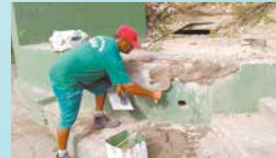
Reparo na mureta da Av. Getúlio Vargas
