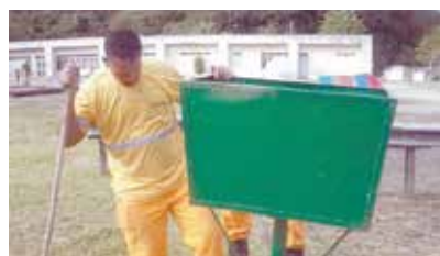
Instalação de lixeiras na Rodovia Rio-Santos, Fazenda Cabuçu e Sítio Caeté - Caruara
