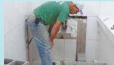
Colocação de pia na guarita da Lagoa da Saúde - Nova Cintra
