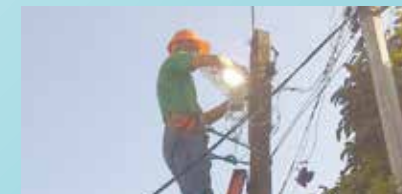
Colocação de refletores na Rua F - Morro José Menino
