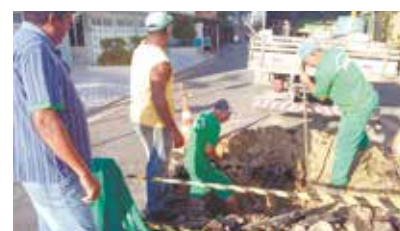
Reparo em abatimento na Rua Adolfo Lutz com Rua Irmão José Isidoro - Ponta da Praia
