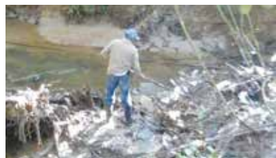
Limpeza e retirada de vegetação do Rio Iriri-Macuco - Caruara
