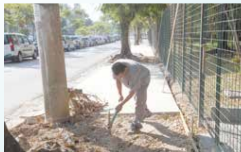
Preparação para concretagem da calçada do Teatro Municipal - Vila Mathias
