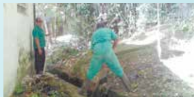
Limpeza da Escola Bartolomeu de Gusmão - Saboó
