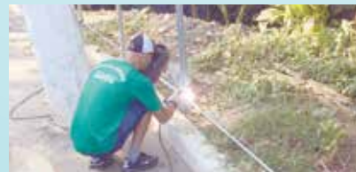
Colocação de alamedados na Rua 1 - Morro Santa Maria
