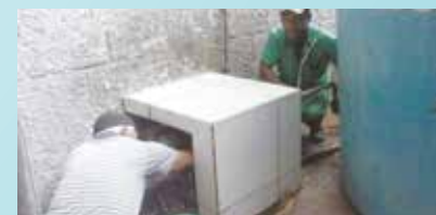
Substituição de moto bomba na UME Wanderley de Almeida - Santa Maria
