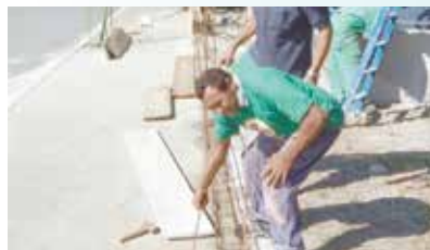
Construção de baldrame para elevação de muro na Sociedade Esportiva - Caruara
