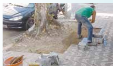
Reparo em calçadas danificadas por raízes - Marapé
