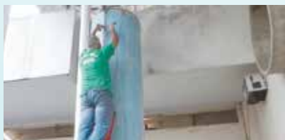
Instalação da iluminação no pátio da UME Oswaldo Justo - Chico de Paula
