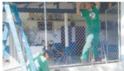
Colocação de tela alamedada na Sociedade Esportiva - Caruara
