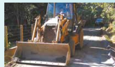
Nivelamento da Travessa Antônio Mineiro - Caruara
