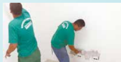
Preparação para pintura e eliminação de rachaduras nas salas do Senat - Bom Retiro
