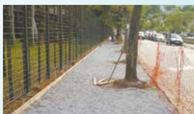
Preparação para concretagem da calçada do Teatro Municipal - Vila Mathias
