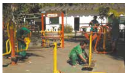
Lixamento das ferragens para posterior pintura da academia ao ar livre na Praça Encarnacion Alves Corpas - Caruara
