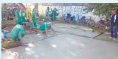
Concretagem do piso da Praça Albertino Moreira - Caneleira
