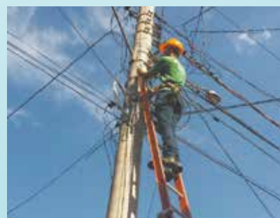
Reparo em caixa de luz na Rua São Cristóvão - Morro São Bento
