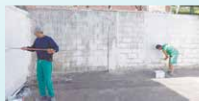
Pintura externa dos muros do Serfis - Rádio Clube
