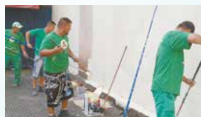
Pintura da fachada do Mercado Municipal - Vila Nova
