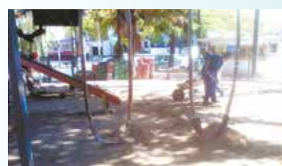
Colocação de piso de borracha na Praça Palmares - Embaré
