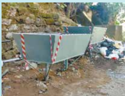
Colocação de lixeiras na Vila Baiana - Morro José Menino
