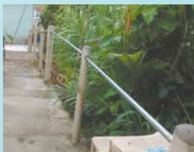
Continuação da escadaria São Domingos - Morro São Bento
