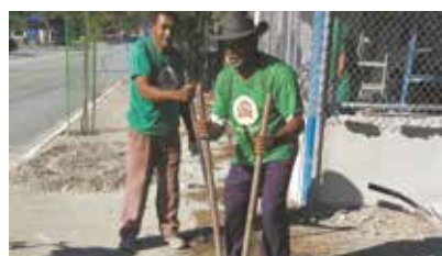
Construção de pilares para edificação de muro na Sociedade Esportiva - Caruara
