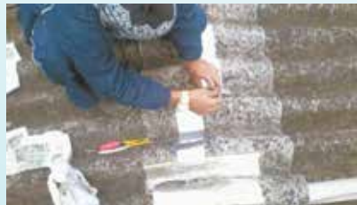
Reparo no telhado na UME Maria de Lourdes Bernal - Jardim Castelo
