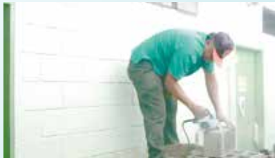
Fechamento de parede da Seacolhe na Rua Bittencourt - Vila Nova
