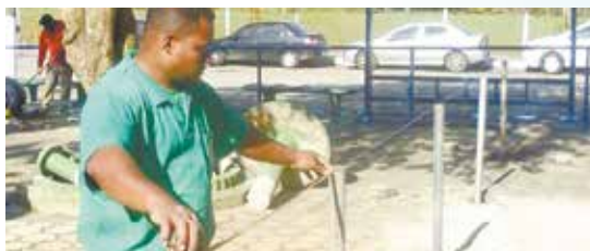
Chumbamento dos canos para tela alambreada para futura academia ao ar livre e cimentado da praça principal - Monte Cabrão
