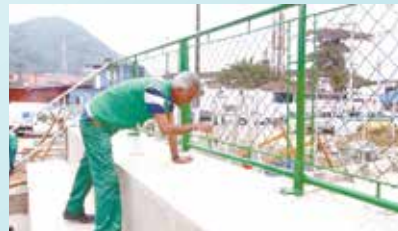
Pintura do alambrado da arquibancada da Praça Guilherme Délius - Vila Haddad
