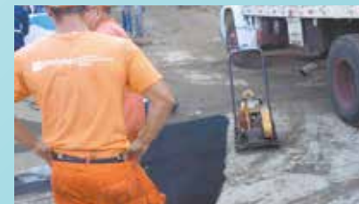
Pavimentação com piso asfáltico na Rua das Pedras - São Bento
