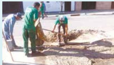
Confeção de rampa de acesso na Praça Guilherme Délius - Vila Haddad
