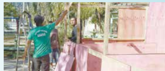
Montagem de barracas na Praça Encarnacion Alves Corpas - Caruara
