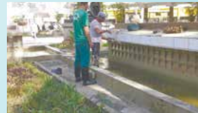
Instalação de pingadeira na fonte da Praça Mauá - Centro
