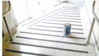
Colocação de fitas antiderrapantes no prédio Seges - Centro
