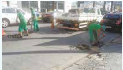
Reparo em abatimento, substituição de poço de visita e boca de lobo na Ana Costa - Vila Mathias
