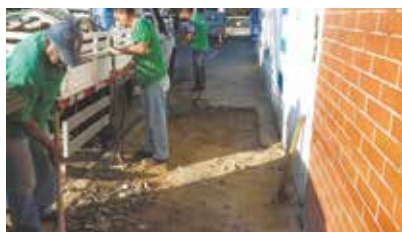
Reparo em calçada danificada por raízes de árvores na Rua Júlio Conceição - Vila Mathias
