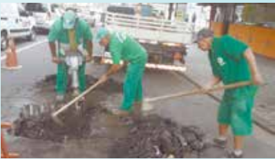
Reparo em abatimento na Av. Afonso Pena
