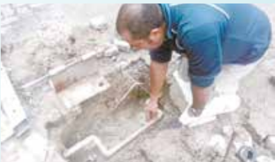
Conserto hidráulico na Arena Santos - Vila Mathias
