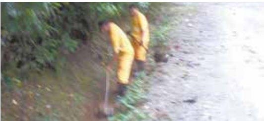
Desobstrução de valas na Rua Oliveira - Caruara
