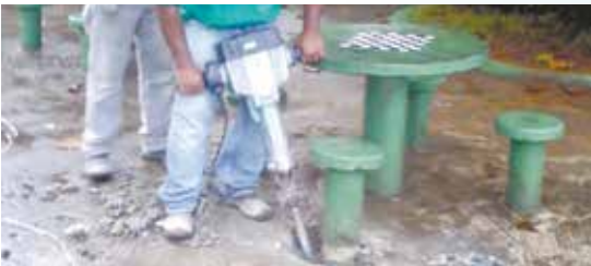
Retirada de mesas e banquetas para futura instalação de academia ao ar livre na praça principal - Monte Cabrão
