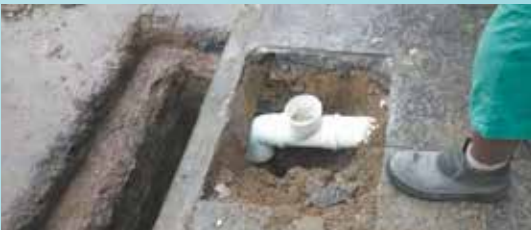
Reparo em rede de drenagem na Rua 4 - Nova Cintra
