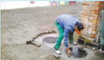
Troca de poços de visita no Cais Vila Mathias
