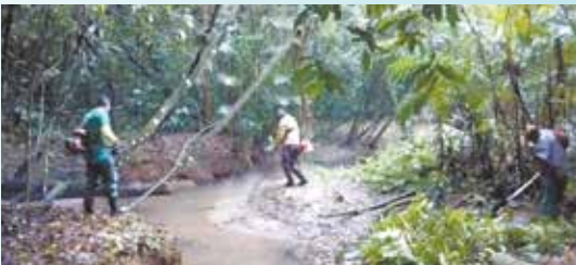
Roçada de mato do canal de drenagem da Rua Oliveira - Caruara
