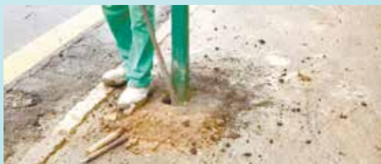
Recolocação de ponto de ônibus na Av. Antonio Manoel de Carvalho - Marapé
