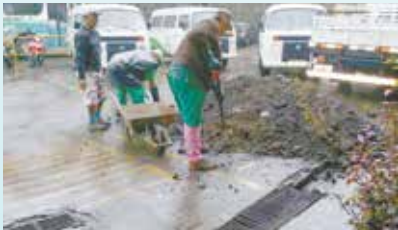
Aterro na Sup-ZNO para execução de contra piso na área do almoxarifado da limpeza
