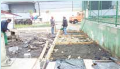
Madeiramento e concretagem do piso na Praça Guilherme Délius - Vila Haddad
