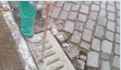
Troca de grelha na Rua Visconde do Rio Branco com Rua da Constituição - Centro
