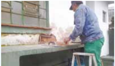
Manutenção civil da Seas na Av. Pinheiro Machado - Vila Nova
