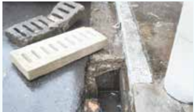
Substituição de boca de lobo na Rua Vasconcelos Tavares com Rua Amador Bueno - Centro
