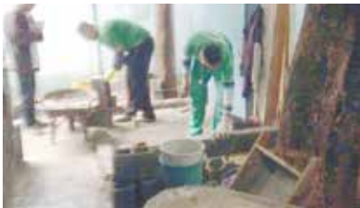
Construção de espaço para vestiário no Iveta Mesquita - Ponta da Praia
