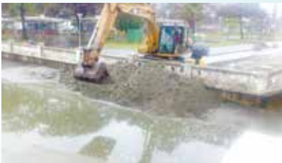
Remoção e transporte de areia do canal 1 para praia da Ponta da Praia e Aparecida
