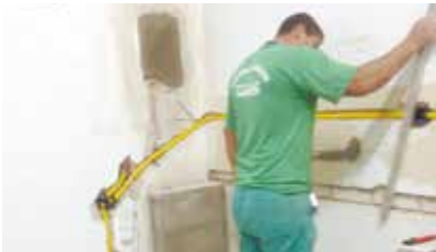
Colocação de pia na sala dos professores na UME Olavo Bilac - Vila Belmiro
