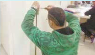
Troca de dobradiças e manutenção das maçanetas da UBS Campo Grande
