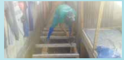
Recuperação de passarela do Caminho da Capela - Rádio Clube
