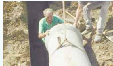
Execução de rede de drenagem na Rua Amador Bueno ao lado do Cemitério do Paquetá
