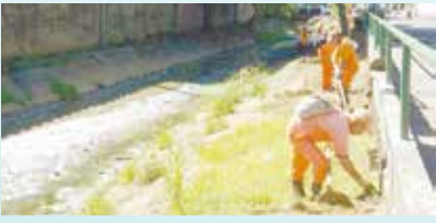
Capinação e limpeza de talude no canal da Rua Maria Mercedes Féa - Saboó
