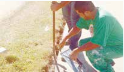
Colocação de cordonéis no Largo Fernando Pessoa - Vila Mathias
