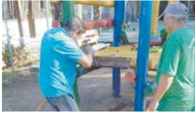
Troca do escorregador do playground da UME Noel Gomes Ferreira - Caruara
