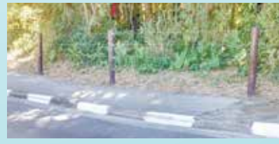
Manutenção de mourões no entorno da Lagoa da Saudade - Nova Cintra
