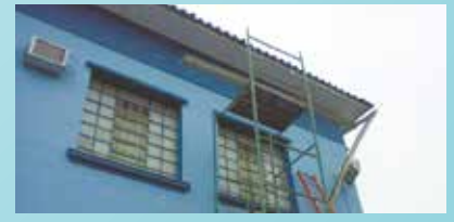
Instalação de calhas na UME Martins Fontes - Morro da Penha
