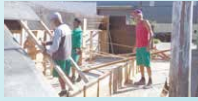
Madeiramento de estrutura da arquibancada na Praça Guilherme Délius - Alemoa
