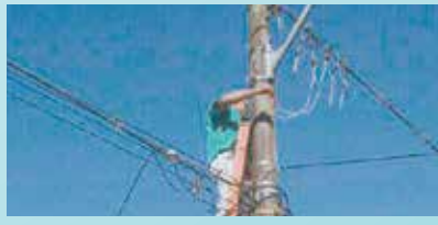
Retirada de caixa de luz na Rua Engenheiro José Garcia - Jabaquara
