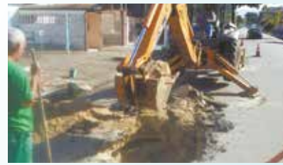
Reparo em abatimento na Rua Padre Anchieta - Macuco
