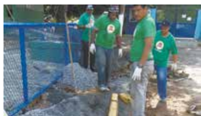
Colocação de meio fio para reparo na calçada e rampa de acessibilidade em praça - Monte Cabrão
