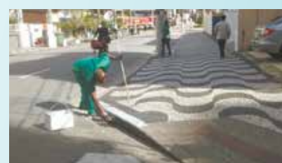
Pintura de guias na Rua Galeão Carvalho - Gonzaga
