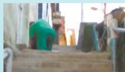
Reparos nos cantos da escadaria São Domingos - São Bento
