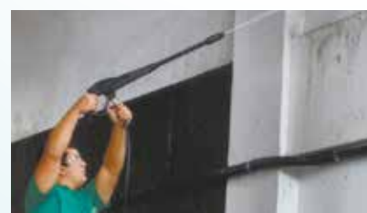
Lavagem das paredes de anexo do Mercado Municipal
