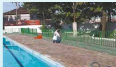
Pintura do gradil no Centro Poliesportivo M. Nascimento - Bom Retiro
