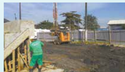
Continuação do nivelamento do piso da Praça Guilherme Délius - Vila Haddad
