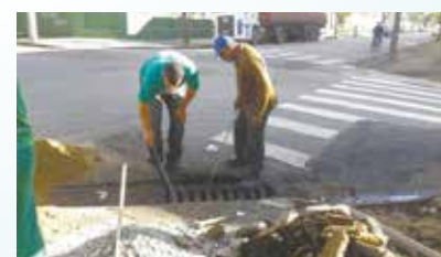
Conserto de calçada e rampa de acessibilidade na Rua Silva Jardim com Rua Emílio Ribas
