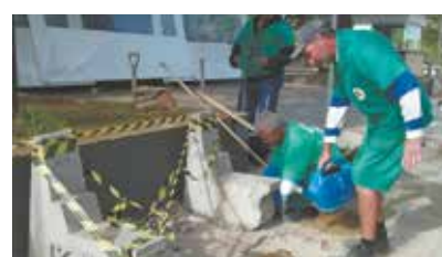
Colocação de banco no canal 1 na orla da praia
