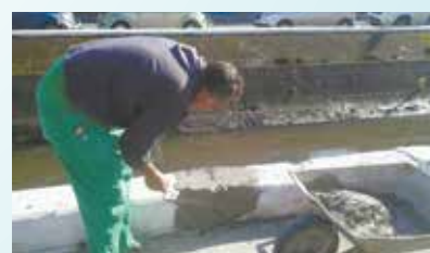
Conserto de mureta no canal da Campos Sales
