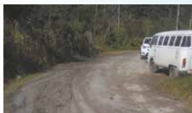
Nivelamento no acesso ao Monte Cabrão
