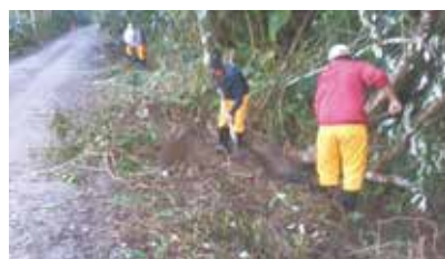
Desobstrução das valas de drenagem - Iriri
