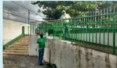
Pintura do gradil do Centro Poliesportivo M. Nascimento - Bom Retiro
