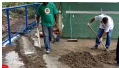
Cimentado no piso da Praça - Monte Cabrão
