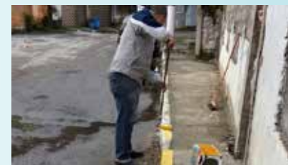
Pintura de sarjeta na faixa amarela na Rua Principal - Monte Cabrão
