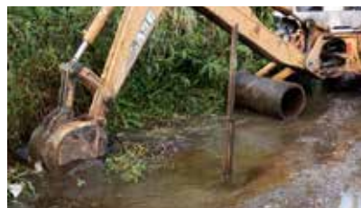
Desobstrução e troca de manilhas drenagem no acesso - Monte Cabrão
