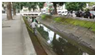
Manutenção do talude do Canal 3 - Boqueirão
