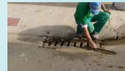
Substituição de grelhas na Rua Pego Júnior com Rua da Constituição - Vila Mathias
