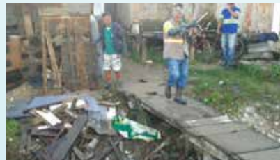
Limpeza de canal da Última Ponte - Rádio Clube
