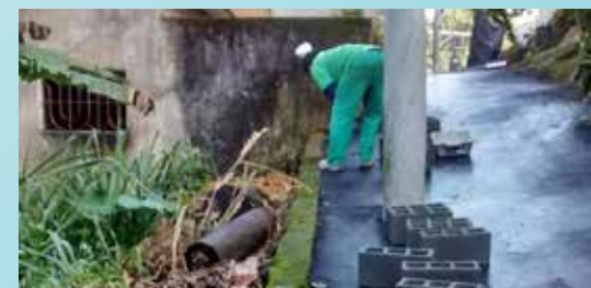
Início de mureta na Rua F - José Menino
