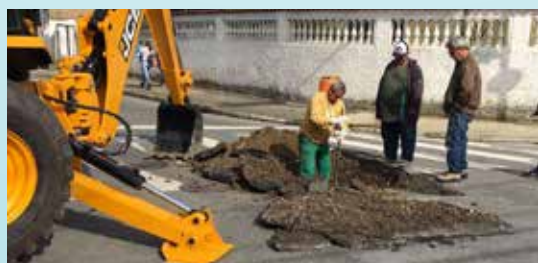
Tapa buraco na via pública e preparação piso asfáltico na Rua Torquato Dias - Nova Cintra
