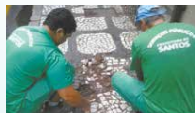
Conserto de calçada na Rua Riachuelo - Centro
