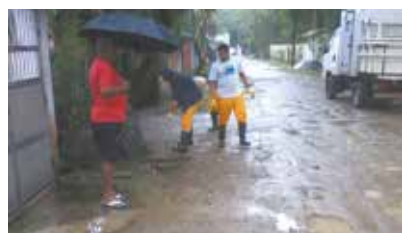
Desobstrução da vala de drenagem da Rua São José - Caruaru
