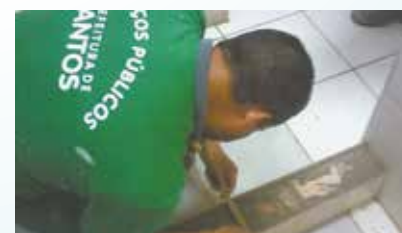
Colocação de box de banho para os funcionários do Detec - Centro
