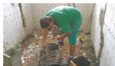
Reforma do banheiro do Seabrigo - Boqueirão
