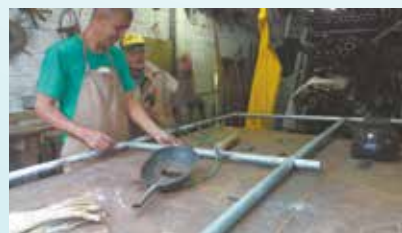
Painéis para fechamento da área de skate na Av. Afonso Schmidt - Rádio Clube
