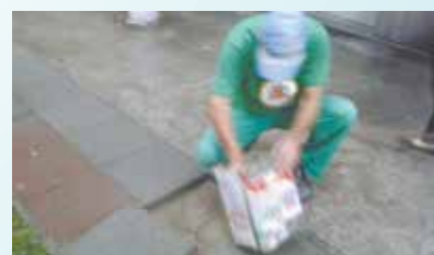
Nivelamento de piso no bulevar da Rua Riachuelo - Centro
