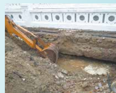
Reparo em abatimento no calçadão da mureta no canal 2, trecho da praia - Pompeia
