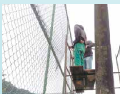
Colocação de alambrado no campo da Praça Guilherme Délius - Alemoa
