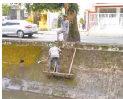
Lavagem do talude no canal 3 x Joaquim Távora
