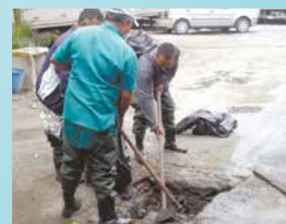
Limpeza de drenagem na Rua Particular Antonio Francisco Lourenço - Chico de Paula
