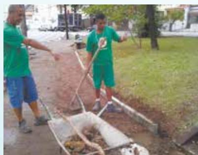
Colocação de cordonéis na Praça André Freire - Vila Mathias
