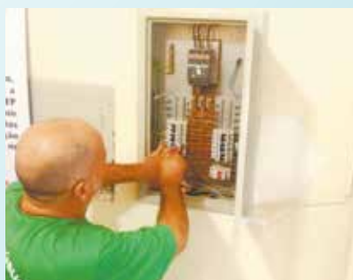
Troca de disjuntor e tomadas no Secraids, sala da farmácia - Vila Mathias
