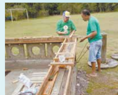
Continuação do madeiramento, concerto do reboco da mureta na Soc. Esp. de Caruara
