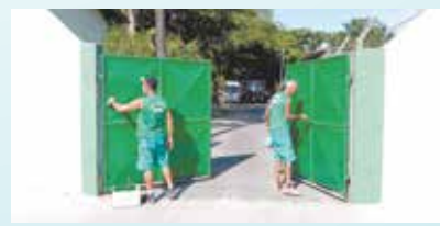
Pintura de portões no Jardim Botânico - Bom Retiro
