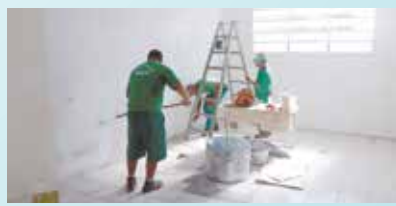
Pintura das salas do SERFIS, incluindo reparos em rachaduras - Bom Retiro
