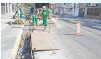
Concretagem da sarjeta na Rua Alfaia Rodrigues - Embaré
