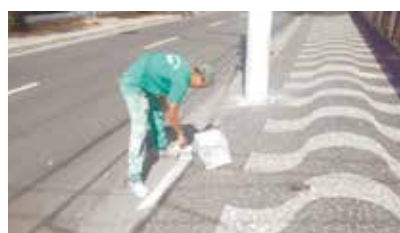
Pintura de postes no canal 5 - Aparecida
