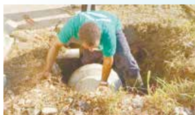
Construção de caixa de drenagem na Rua Três - Caruara
