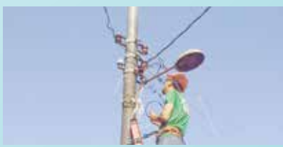
Instalação de caixas de luz em diversos locais no Morro José Menino
