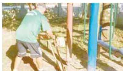
Reparo e troca dos pontaletes no playground na UME Judoca Ricardo Sampaio - Caruara
