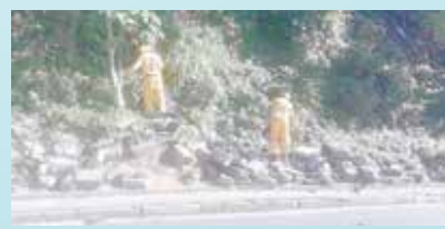
Limpeza de encosta na Rua São Roque - Morro São Bento
