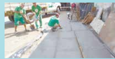
Confeção de 16 tampas de concreto para serem colocadas em diversos pontos - Morro José Menino
