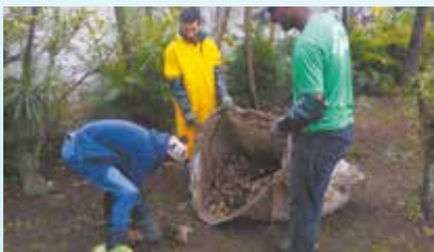
Limpeza de terreno na Av. Brigadeiro Faria Lima - Rádio Clube
