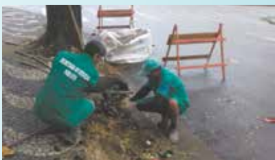
Reparo em calçada com mosaico na Rua Napoleão Laureano com Alfredo Albertin - Marapé
