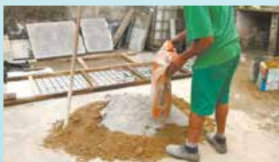
Confecção de tampas de drenagem para serem utilizadas em diversos morros
