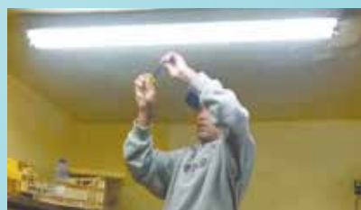
Troca de lâmpadas na Creche Solar dos Anjos - Nova Cintra
