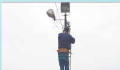
Manutenção em refletores - Morro do Bufo
