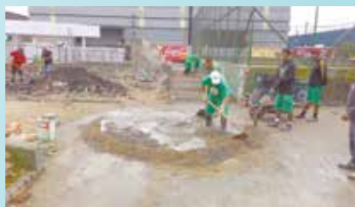
Execução de rampa de acesso para arquibancada na Praça Guilherme Delius - Vila Haddad
