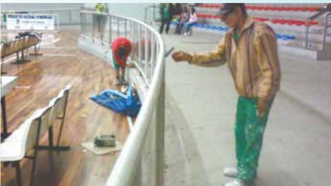
Pintura do guarda corpo na Arena Santos - Vila Mathias
