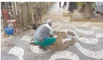
Finalização dos trabalhos na calçada danificada na Rua Carlos Afonseca - Gonzaga
