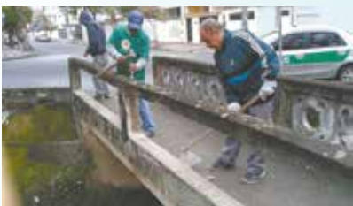
Reparo na passarela Rua Saturnino de Brito com Moura Ribeiro - Marapé
