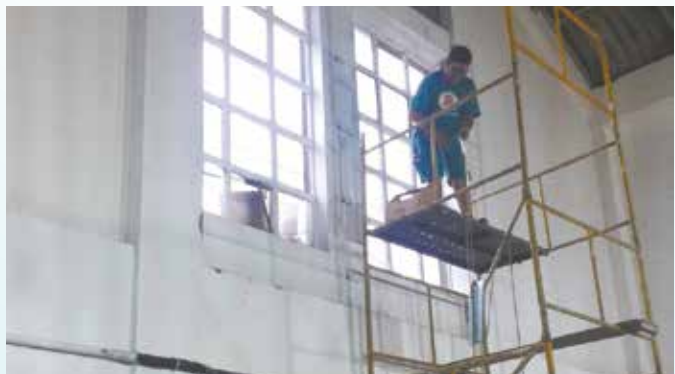
Colocação de vidros em anexo ao Mercado Municipal - Vila Nova
