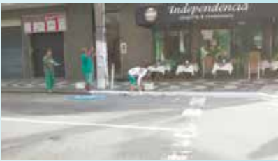
Pintura de guias e postes na Praça Independência com Rua Floriano Peixoto - Gonzaga
