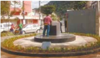
Finalização da manutenção da Praça André Di Fazio - Vila Mathias
