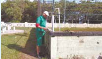
Acabamento nas muretas do campo da Praça Euzébio Rocha - São Manoel
