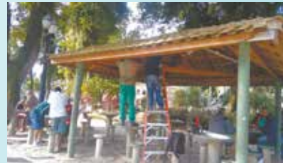
Troca de reatores e lâmpadas no quiosque da Praca José Bonifácio - Centro
