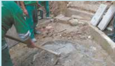
Colocação de tampas de drenagem na viela da Rua F - José Menino
