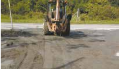
Nivelamento da rua de acesso - Monte Cabrão
