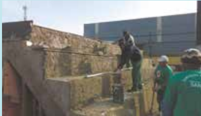
Reboco dos degraus da arquibancada na Praça Guilherme Délius - Vila Hadad
