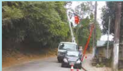
Manutenções elétricas na Av. Brasil - Nova Cintra
