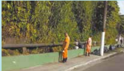
Limpeza de drenagem na Av. Martins Fontes - Penha
