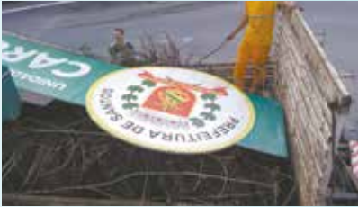
Retirada de placa e pintura das salas na futura Vila Criativa - Caruara
