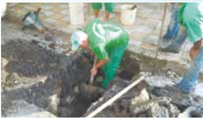
Reparo em abatimento e colocação de boca de lobo na Rua Pedro Américo - Campo Grande
