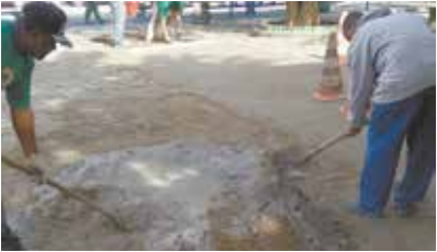
Cimentado do piso na praça - Monte Cabrão
