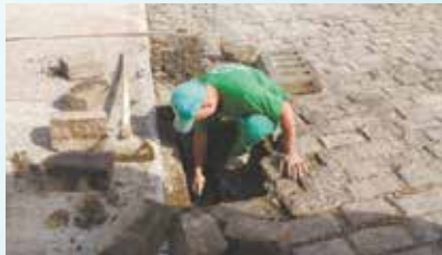
Renivelamento de poço de visita e boca de lobo na Rua Anhaguera - Vila Nova
