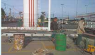
Colocação de alambrado para fechamento da área de skate na Av. Afonso Schmidt
