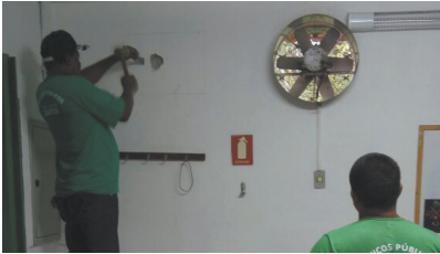
Quebra de paredes para instalação de ar condicionado no Cecom - Caruara
