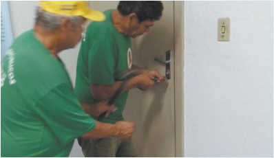
Troca de fechadura na sala da Saaf - Caruara
