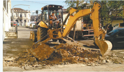
Demolição para posterior calçada nova na Rua Bittencourt - Vila Nova
