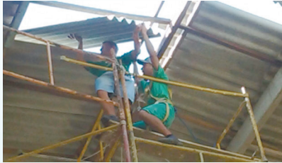
Colocação de telhas no Instituto Querô - Vila Nova
