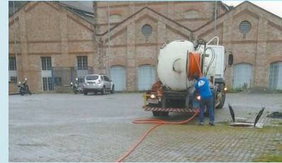
Identificação de redes de água e esgoto no Arena Santos - Vila Mathias
