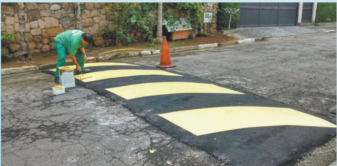
Continuação de pintura de lombadas - Rua Maria dos Reis - Nova Cintra
