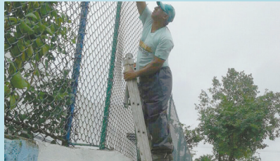
Revisão final da pintura na UBS Bom Retiro
