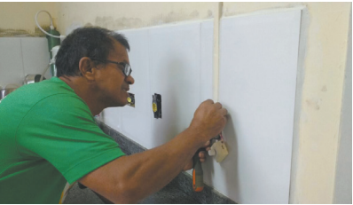
Colocação de azulejo no lactário da UME Andradas - Aparecida
