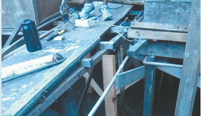
Recuperação de passarela no Caminho São Sebastião - Rádio Clube
