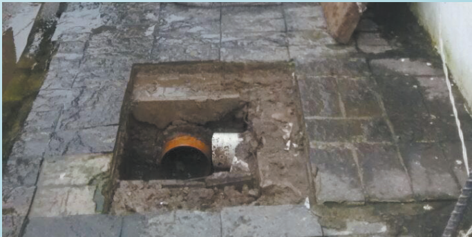
Desobstrução de caixa de passagem na Rua 4 - Nova Cintra
