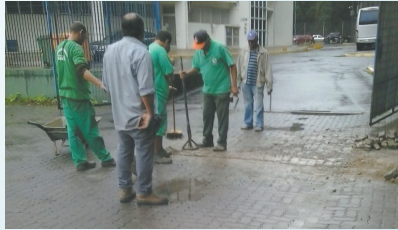
Reparo em piso no Arena Santos para Festa Inverno Quente - Vila Mathias
