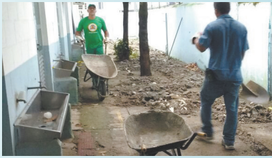
Demolição dos bancos na UME Iveta Mesquita Nogueira - Ponta da Praia
