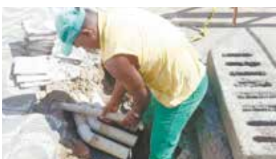
Abatimento e troca de grelha de boca de lobo na Rua Maria Máximo - Ponta da Praia
