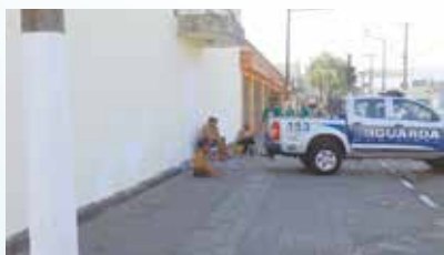
Pintura prédio da Guarda Municipal - Vila Nova
