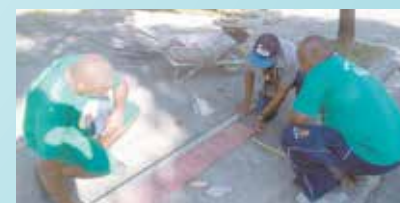
Assentamento do piso podotátil nas rampas de acessibilidade da Praça dos Ex-Combatentes - Rádio Clube
