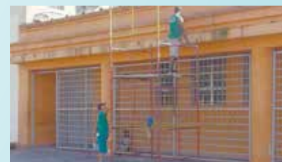
Preparação para pintura do restaurante Bom Prato Mercado - Vila Nova
