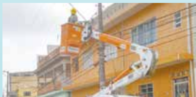
CPFL e SUP-M realizando serviços de elétrica na Rua São Fernando - Morro São Bento
