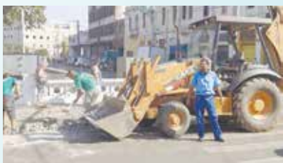
Reparação para nova calçada em concreto despenhado. Canal da Campos Sales - Vila Nova
