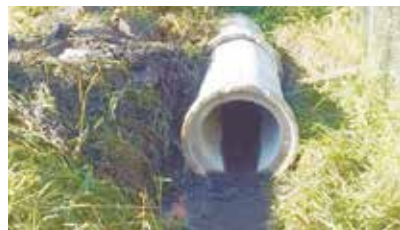
Instalação de manilhas na Rua João Torres - Caruara
