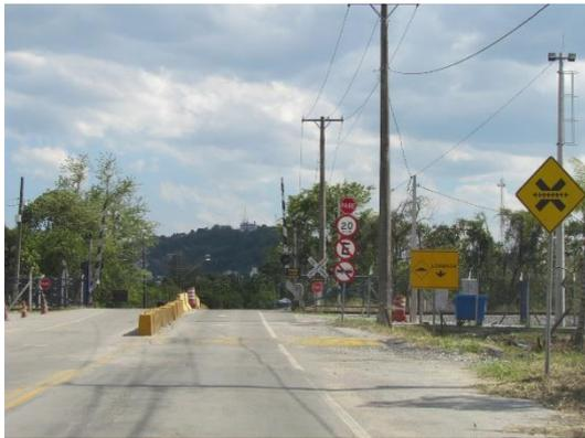
**Foto 2.9.** | Após aproximadamente 1.100 metros do pré gate, encontra-se a passagem em nível sobre a ferrovia. A partir da imagem acima pode-se verificar que a PN encontra-se devidamente sinalizada, utilizando-se de cancelas automáticas e sinaleiras para o fechamento do tráfego rodoviário durante a passagem de composições ferroviárias.
