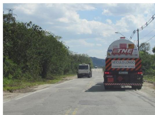
**Foto 2.4. | Estrada Particular da CODESP, sentido Ilha Barnabé. A partir da SP-055, a via desenvolve-se em pista simples, com uma faixa de rolamento por sentido. Nota-se a partir da imagem acima, as condições de conservação do pavimento e das sinalizações horizontais, acostamentos.**
