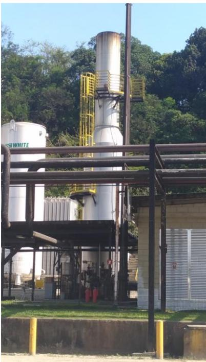
**Figura 2.2 - 1: Foto da chaminé do sistema de controle das emissões atmosférica**
