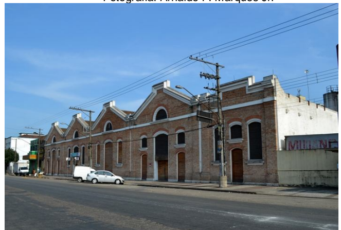
Armazém do início do século XX. Atualmente abriga uma unidade do Poupatempo. Situa-se na rua João Pessoa n.º 246. Fotografia de 2011.
