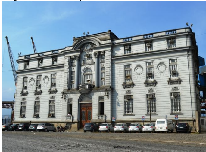
O antigo Escritório Central da Cia. Docas, no cais do Paquetá. Fotografia de 2011.
