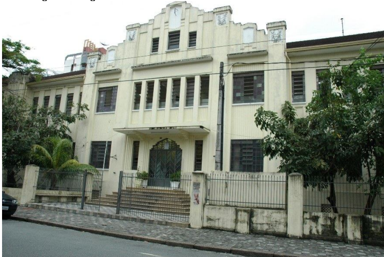
Detalhe da fachada do Colégio Canadá, situado na rua Mato Grosso n.º 163. Fotografia sem data.
