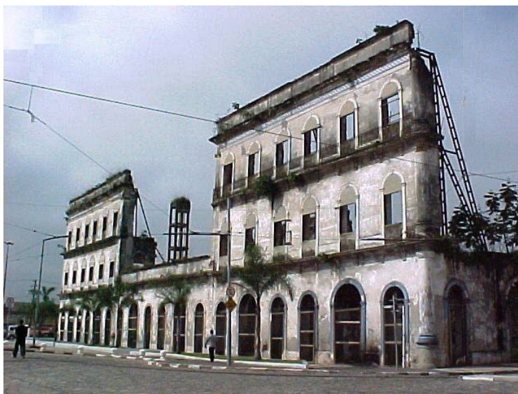
Casarões do Largo Marques de Monte Alegre. O bloco à direita data de 1867 e o bloco à esquerda, de 1872. A fotografia retrata o estado do imóvel em 2002, após os incêndios sucessivos do bloco esquerdo (1985) e direito (1992). Fotografia de 2002.
