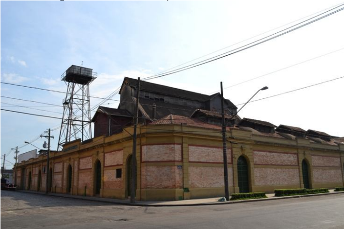
Armazém Roberto. Início do século XX. Situa-se na rua João Pessoa n.º 520. Fotografia de 2011.
