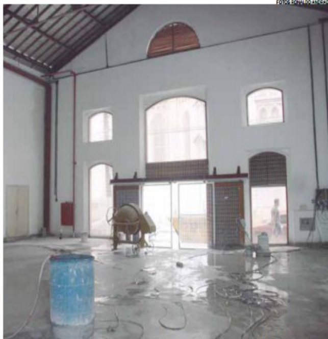
Prédio está recebendo obras de adaptação, com investimento de R$ 522 mil
