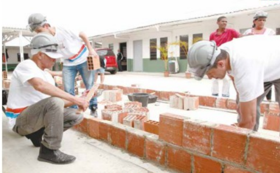
Escola de Construção Civil, com capacitação de pedreiro, encanador e assentador de pisos e azulejos, tem 45 vagas
