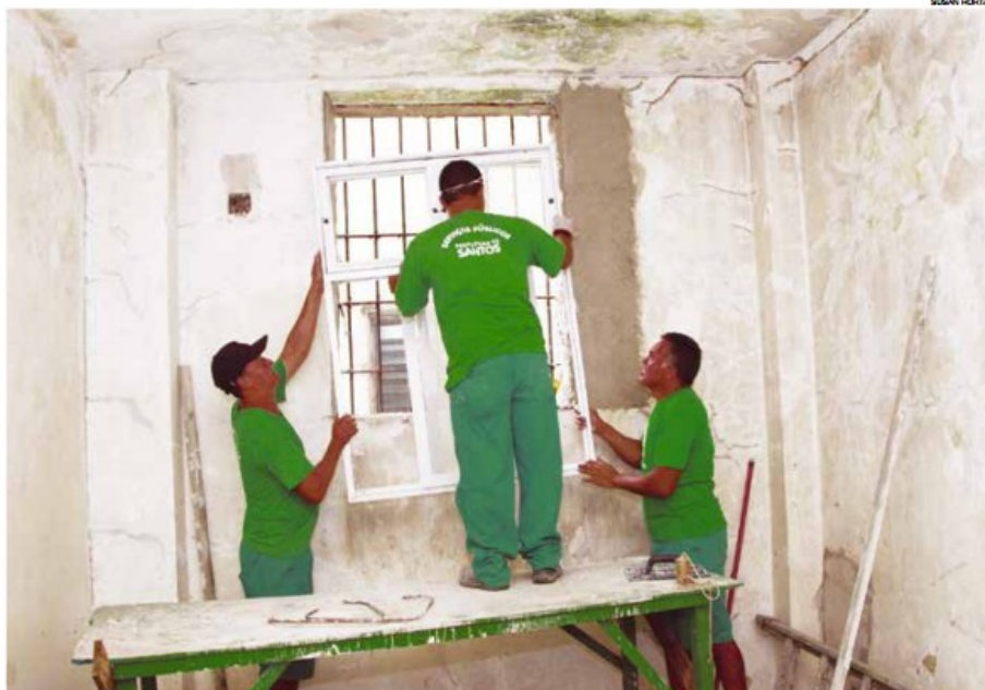
Funcionários substituem os antigos vitrões e telhas e ainda concluirão a restauração da fachada e revisão de instalações
