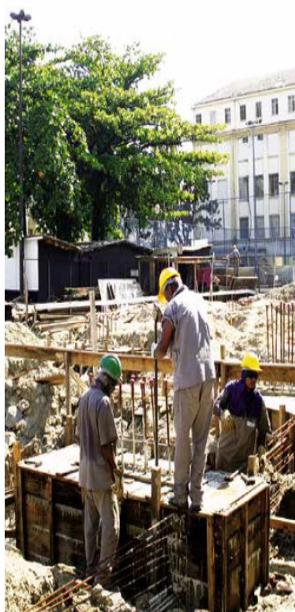
Com remoção de pedras, trabalho envolve 21 operários
