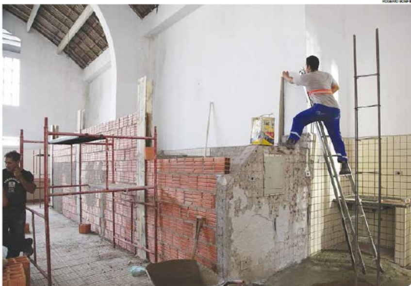
Trabalhos incluem a construção de quatro sanitários, sendo dois adaptados para pessoas com deficiência
