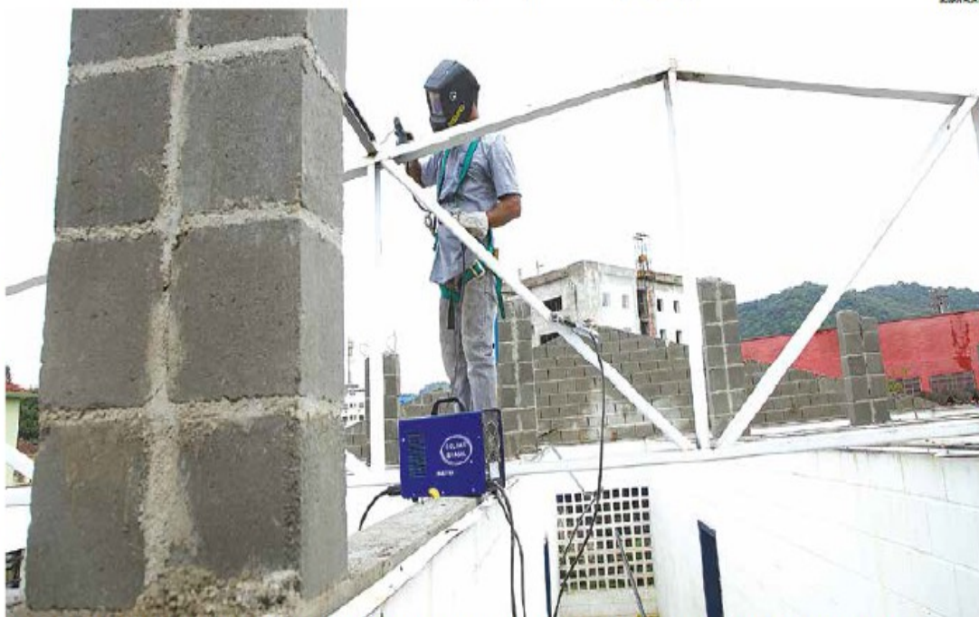
Funcionário realiza serviço na cobertura do prédio anexo ao do centro, que vai receber telhas térmicas em substituição às de cerâmica
