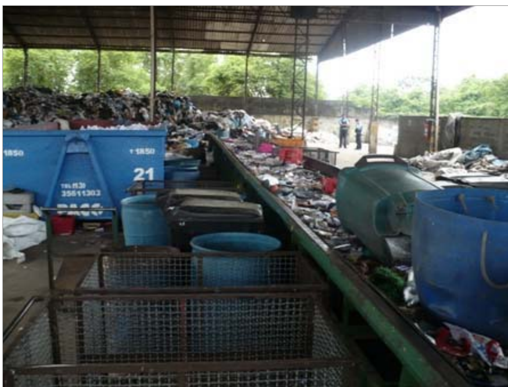
Figura 8.1 - Vista parcial da esteira de triagem no interior da usina. Fonte: Concremat.
