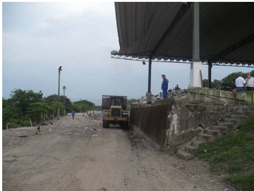
Figura 3.4 - Vista da estação de transbordo – Aterro da Alemoa.
