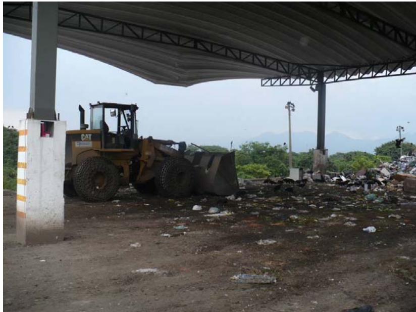
Figura 3.3 - Vista da estação de transbordo – Aterro da Alemoa.
