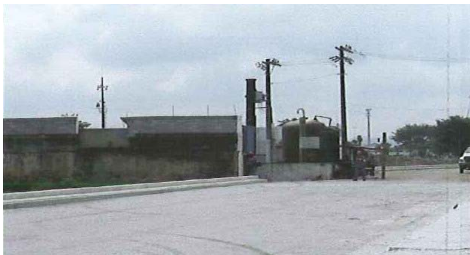
Figura 9 – Estação elevatória VII, a ser reformada.
