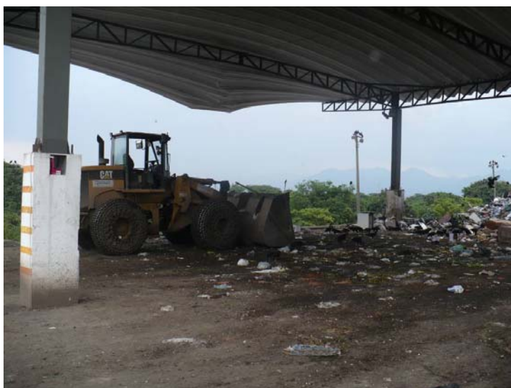
Figura 3: Vista da estação de transbordo – Aterro da Alemoa.
