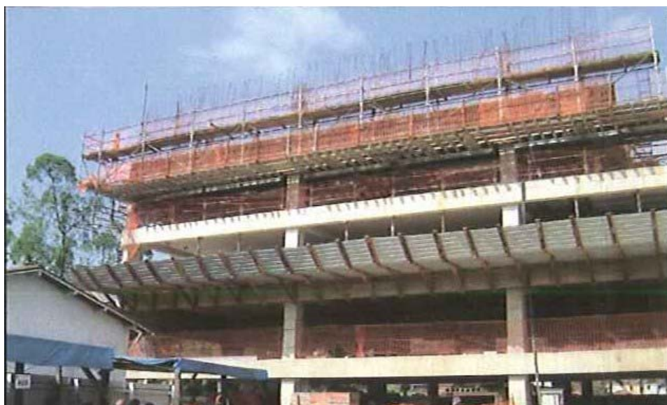
Figura 5 – Vista da obra da nova EPC.
