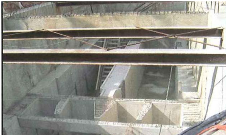
Figura 6 – Obra do poço de chegada e caixa de areia do novo interceptor de Reboças.
