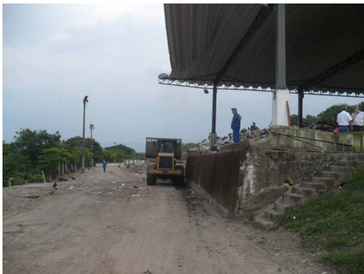
Figura 4: Vista da estação de transbordo – Aterro da Alemoa.
