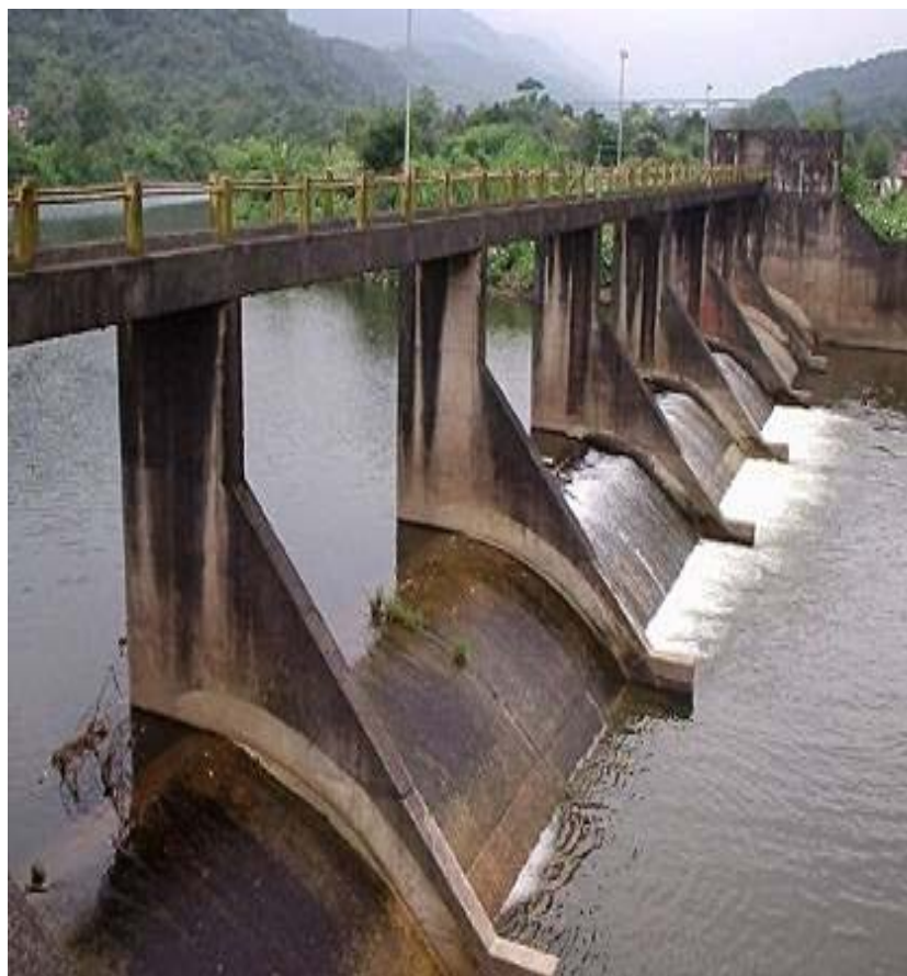
Figura 2 - Vista da Captação Sub-Álvea no Rio Cubatão 5 .
