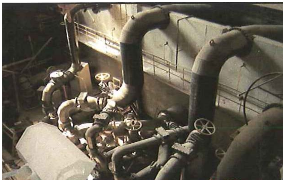
Figura 7 – Estação principal do sistema I-1, a ser reformada.
