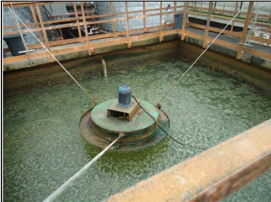
**Figura 8.3 – Reator Aeróbio do sistema de tratamento biológico.**
