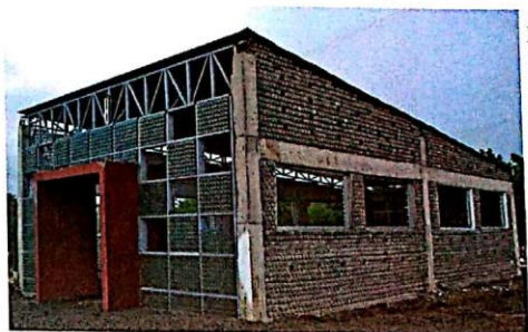
► Bottle School – projeto da Fundação My Shelter –, escola construída com garrafas de plástico PET preenchidas com terra e cimento em San Pablo, Laguna, Filipinas, 2011.
