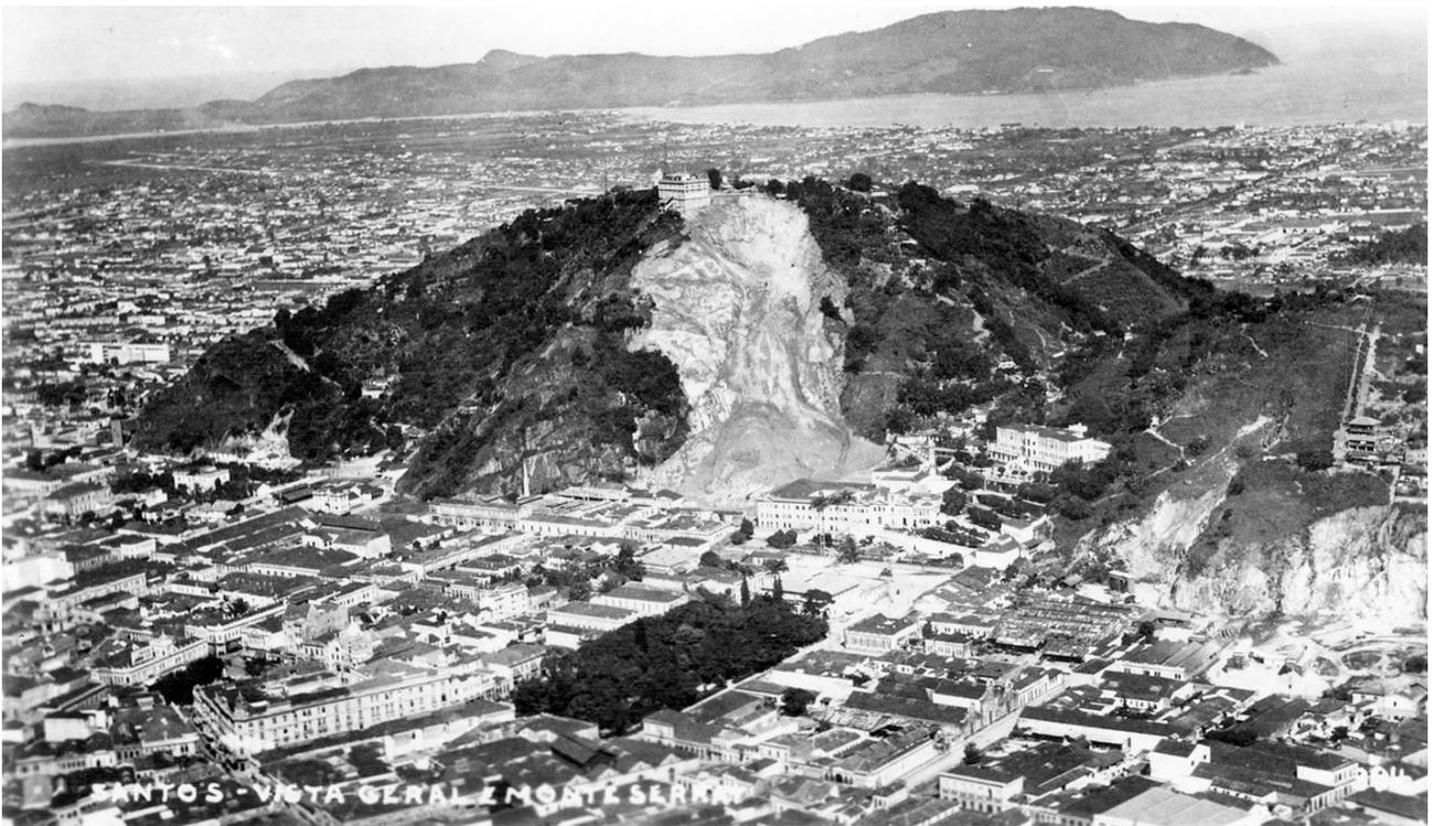
Em março desse ano ocorreram muitos deslizamentos, devido as fortes chuvas na região. As áreas mais atingidas são as encostas dos morros, que devido ao desmatamento, o solo encharca e ocorre o deslizamento de terra e detritos de rocha, provocando prejuízos aos moradores dessas áreas, que são chamadas áreas de risco.
