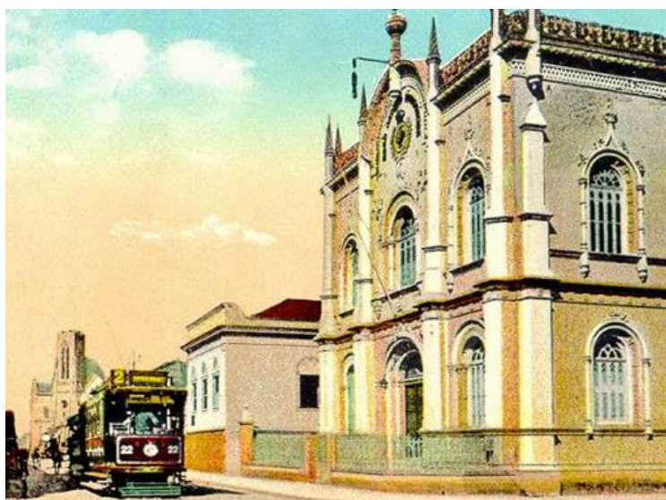
Início do século XX -Rua Amador Bueno, ao fundo catedral sendo construída.
