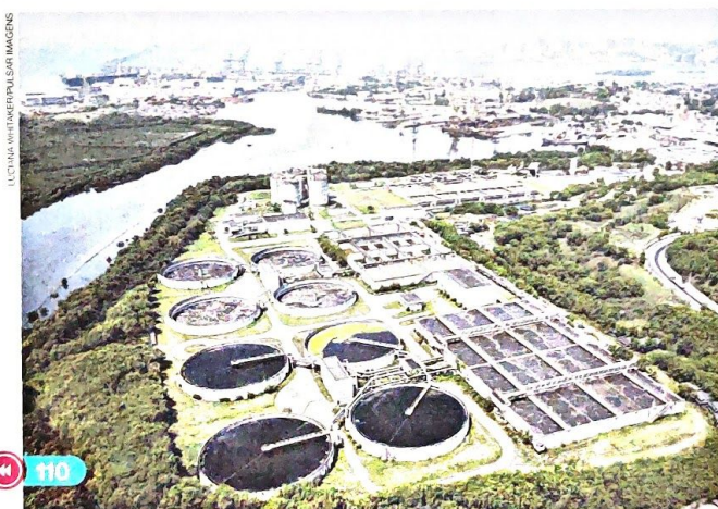
Estação de tratamento de esgoto no município do Rio de Janeiro, estado do Rio de Janeiro, 2015.
