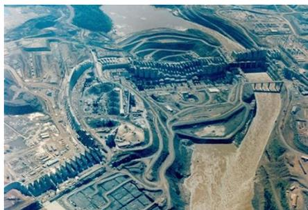
Em sua construção, foi utilizada uma quantidade de mais de 12 milhões de metros cúbicos de concreto, essa quantidade era suficiente para construir mais de 200 Maracanãs. O ferro utilizado em suas
