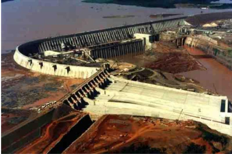
Quatro anos depois do início das obras, o Rio Paraná foi desviado de seu curso original através de canais de desvio construídos para esse fim. Esses canais eram feitos para que a estrutura da usina pudesse ser construída, assim a água corria ao lado do local onde se realizavam as obras. O canal provisório tinha 02 quilômetros de extensão e 80 metros de profundidade.
