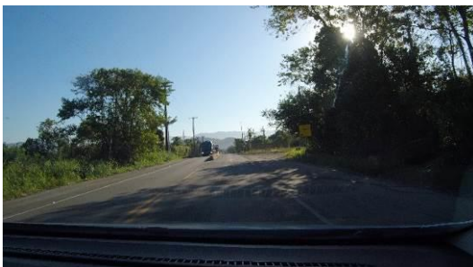
Foto 2.15: Estrada da CODESP, sentido SP-055. Ao fundo da imagem está localizada a passagem em nível objeto do presente relatório.
