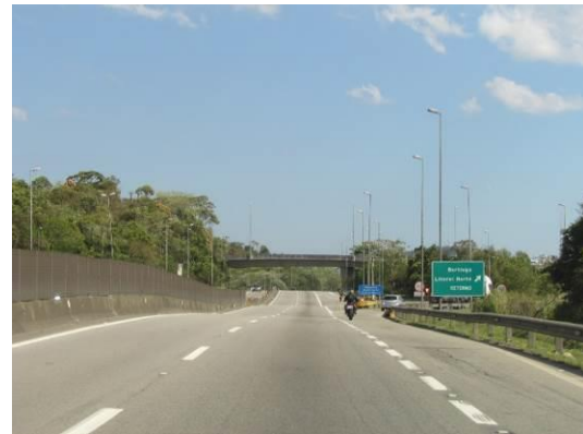
Foto 2.22: SP-055, sentido Guarujá. No km 248 da rodovia, ou seja, aproximadamente 2,5 km do acesso à Ilha Barnabé está localizado o dispositivo de retorno da via. Tal dispositivo possibilita que os veículos com viagem originada nos terminais retomem o trajeto sentido Cubatão e demais localidades.
