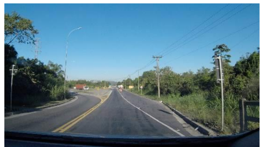
Foto 2.8: Trecho final de Obra de Arte Especial (OAE) sobrepondo curso d’água existente no local.
