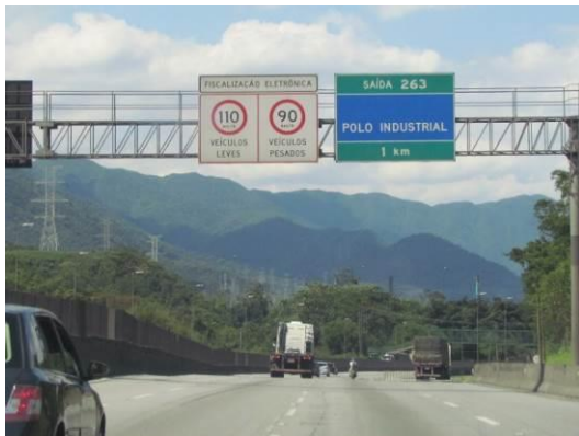
Foto 2.17: SP-055 – Rodovia Cônego Domênico Rangoni, sentido Guarujá, após o acesso à área urbana de Cubatão. Neste trecho a via desenvolve-se em pista dupla, com três faixas de rolamento por sentido. A via encontra-se em bom estado de conservação, com sinalizações horizontal e vertical adequadas. Sua velocidade máxima está regulamentada em 110Km/h para veículos leves e 90km/h para veículos pesados.
