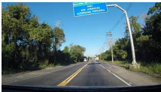
Foto 2.3: Estrada Particular da CODESP. A imagem ilustra ainda o trecho inicial da via de acesso. A placa indica a jurisdição do trecho, delegada à autoridade portuária.
