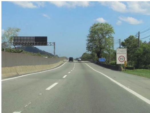
Foto 2.21: SP-055, sentido Guarujá, após o acesso à Ilha Barnabé. Após o acesso, a via possui regulamentação de velocidade máxima em 80 km/h.
