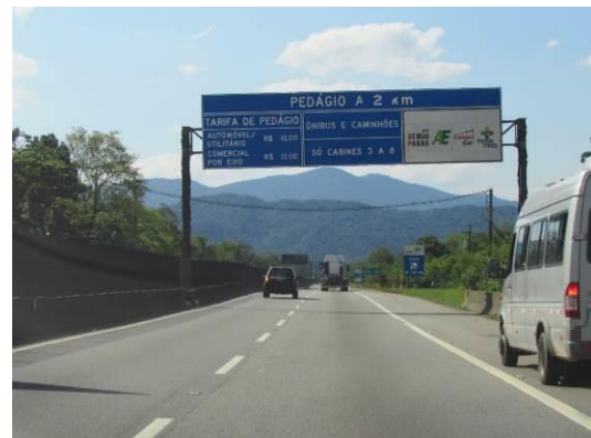
Foto 2.24: SP-055, sentido Cubatão. Próximo ao acesso à Ilha Barnabé está localizada a praça de pedágio da rodovia. A cobrança é realizada apenas na pista sentido Cubatão e, atualmente, a tarifa encontra-se em R$ 12,00 para veículos de passeio e R$ 12,00 para veículos comerciais, por eixo.
