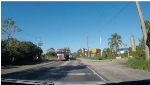
Foto 2.13: Após aproximadamente 1,100 metros do pré gate da AGEO encontra-se a passagem em nível sobre a ferrovia, objeto deste estudo.
