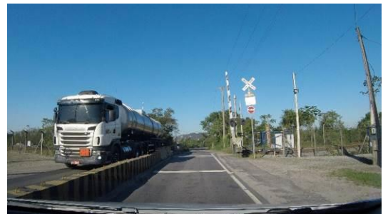
Foto 2.14: Na imagem acima verifica-se que a PN encontra-se devidamente sinalizada, utilizando-se de cancelas automática e sinaleiras para o fechamento do tráfego rodoviário durante a passagem das composições ferroviárias.
